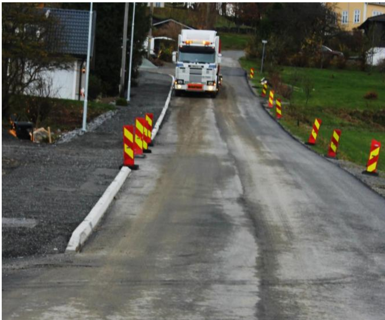
Fortauet langs Halsabrotet er no klårt - berre asfaltering står att
