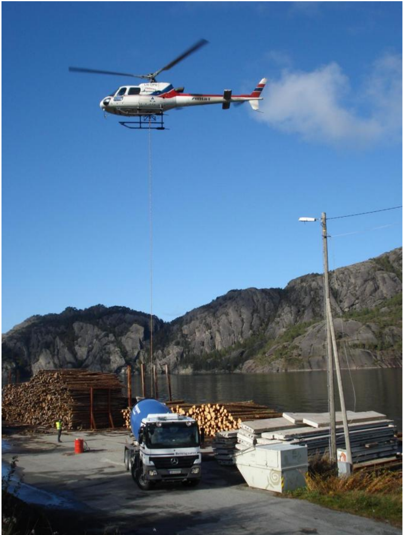
Helikopteret henta betongen frå betongbil som var parkert på Børnes kai(Foto: Thor Inge Døssland)
