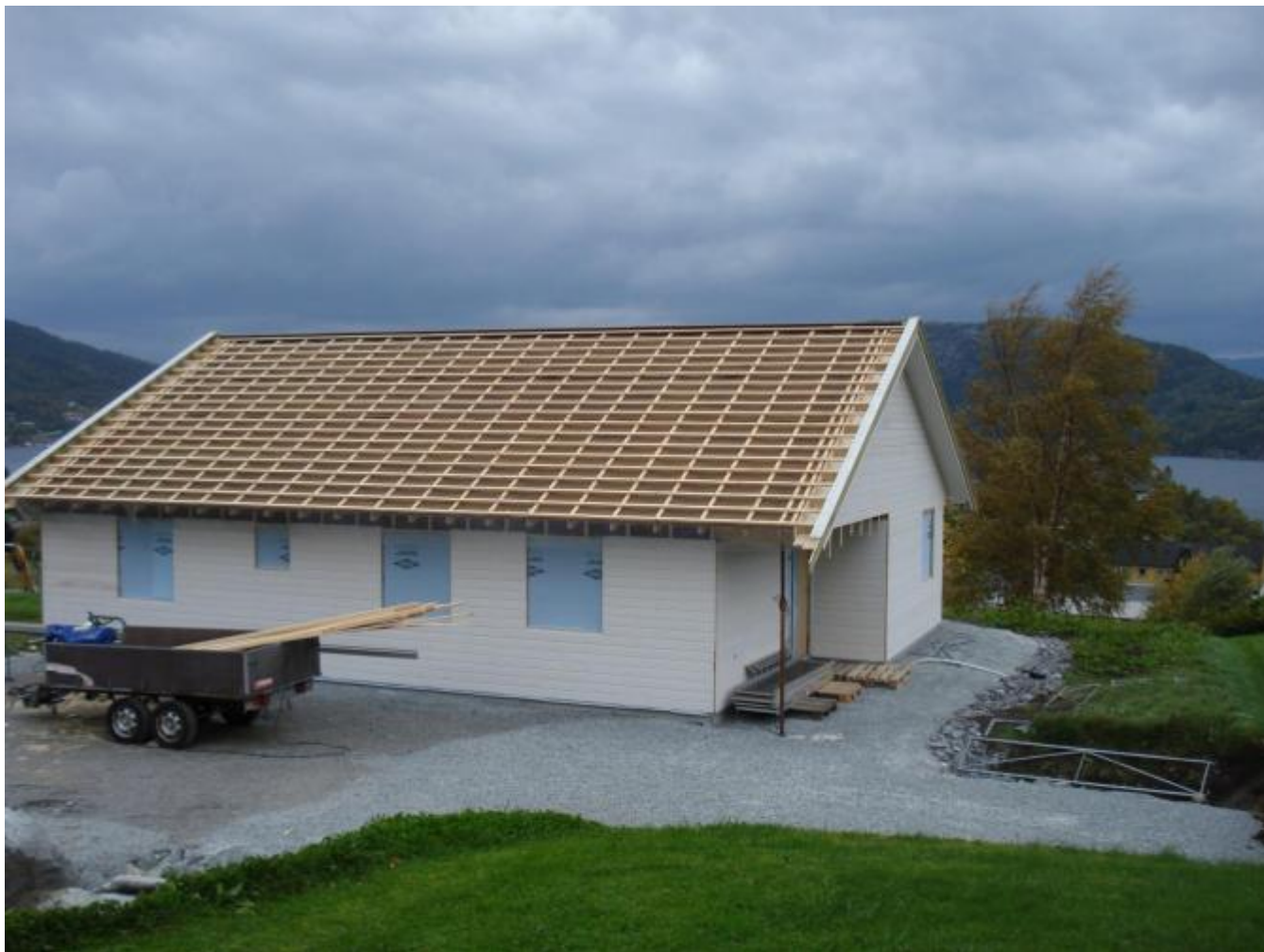
Det går unna i Øvre Halsane. Det første huset er no tett.
