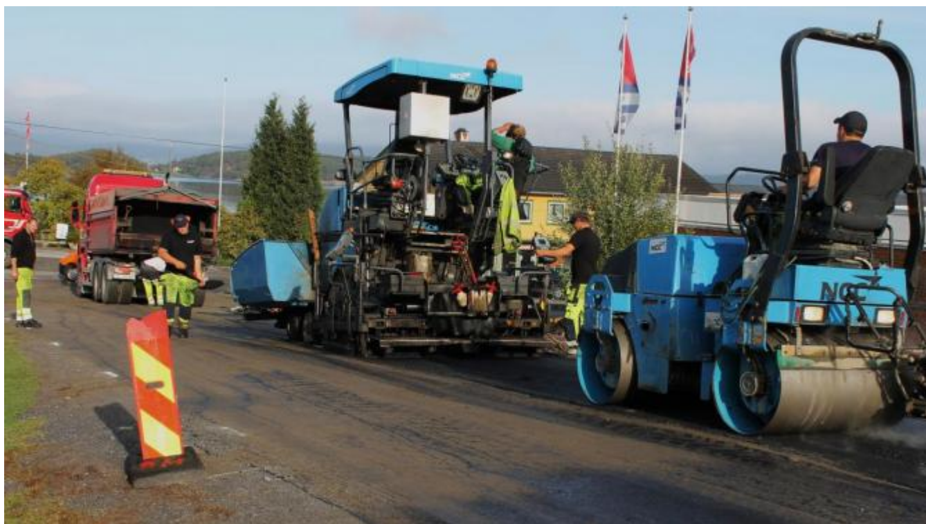
Store mannskaper og mange maskiner er sett inn
