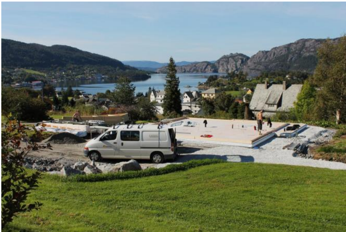
Det første nye huset i Øvre Halsabrotet er under bygging no.
