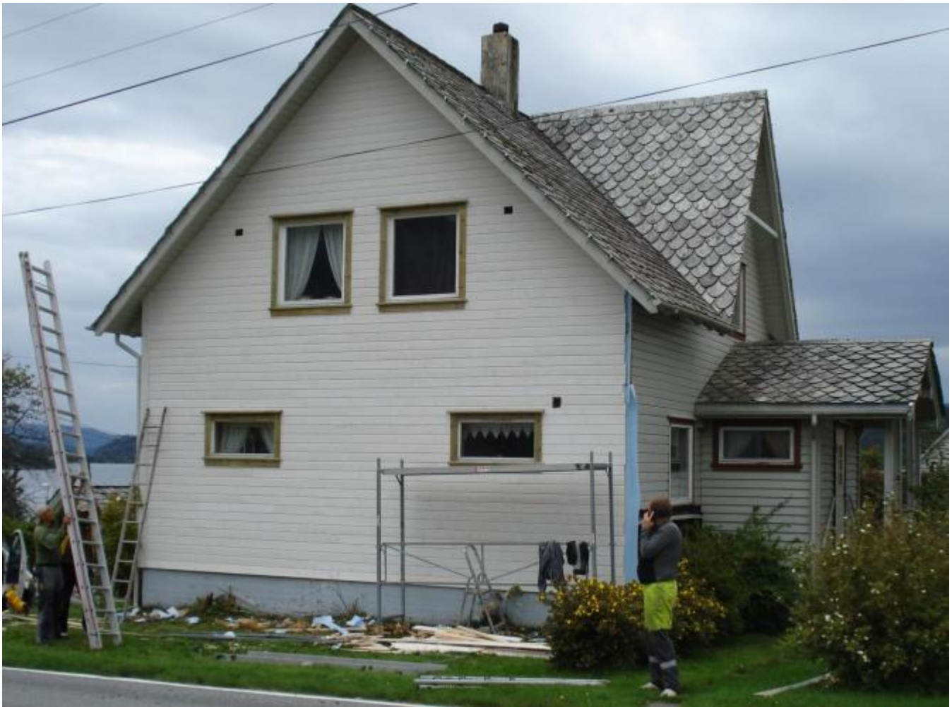
På Brekkeskallen er ei side ferdig bordkledd medan rivinga er i gang på den andre sida. Eldsteson Einar Gjertsen(gul bukse) er ryddegut og administrator.(Klikk på bilda)
