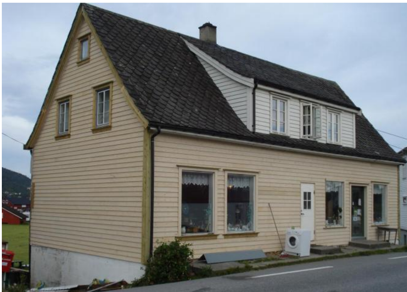
Det gamle Samyrkjelagsbygget framstår verkeleg fint etter arbeidet som er gjort.
