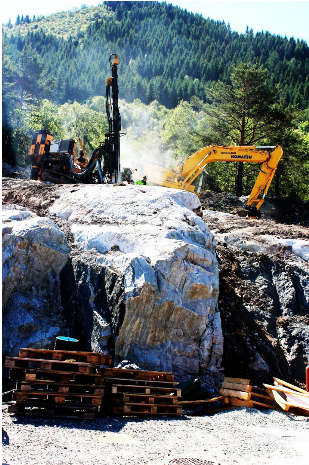
Grunnarbeid framfor neste etappe er igang
