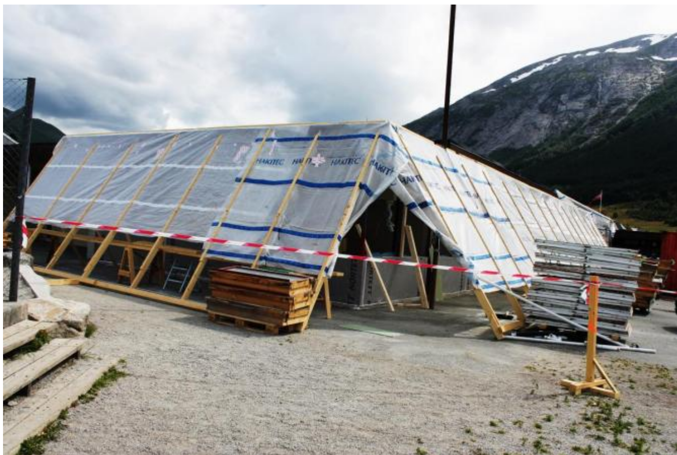
Under plasten gøymmer det seg ein ferdig renovert klasseromsfløy om få veker
