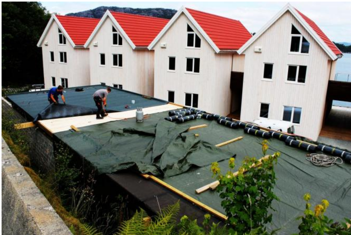
Arbeidet med garasjane er igang no.
