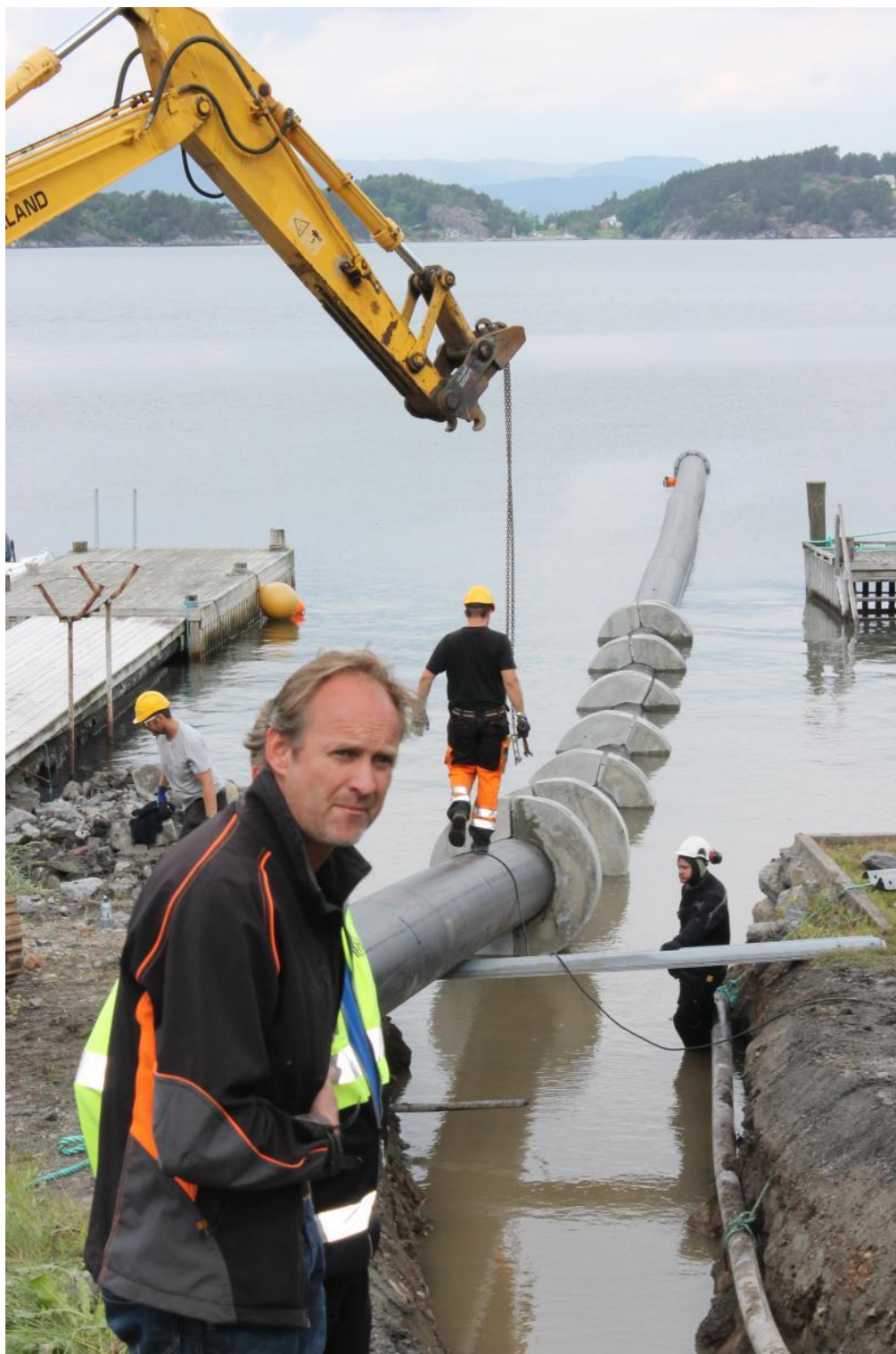
- Det er i Uskedalen det skjer! Gunnar Røssland under utleggjinga av sjøkabelen
