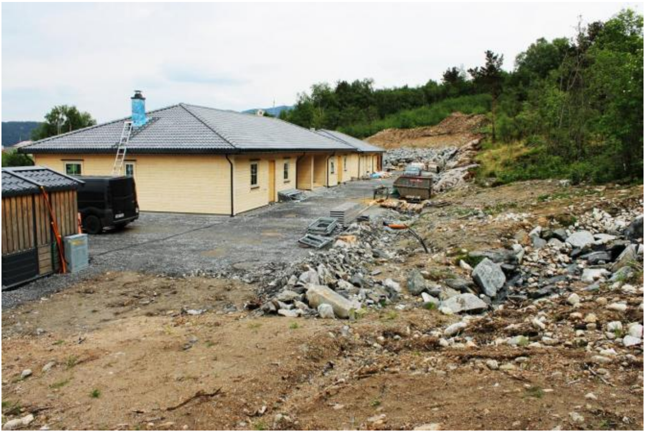
Dei to neste husa skal liggja oppover i skråningen til høgre
