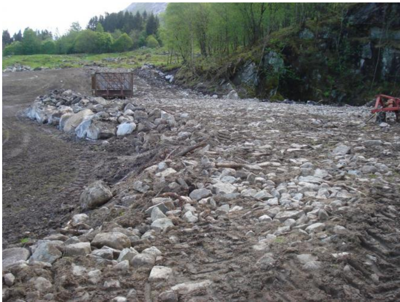
All steinen er blitt fundament for veg og lagringsplass.
