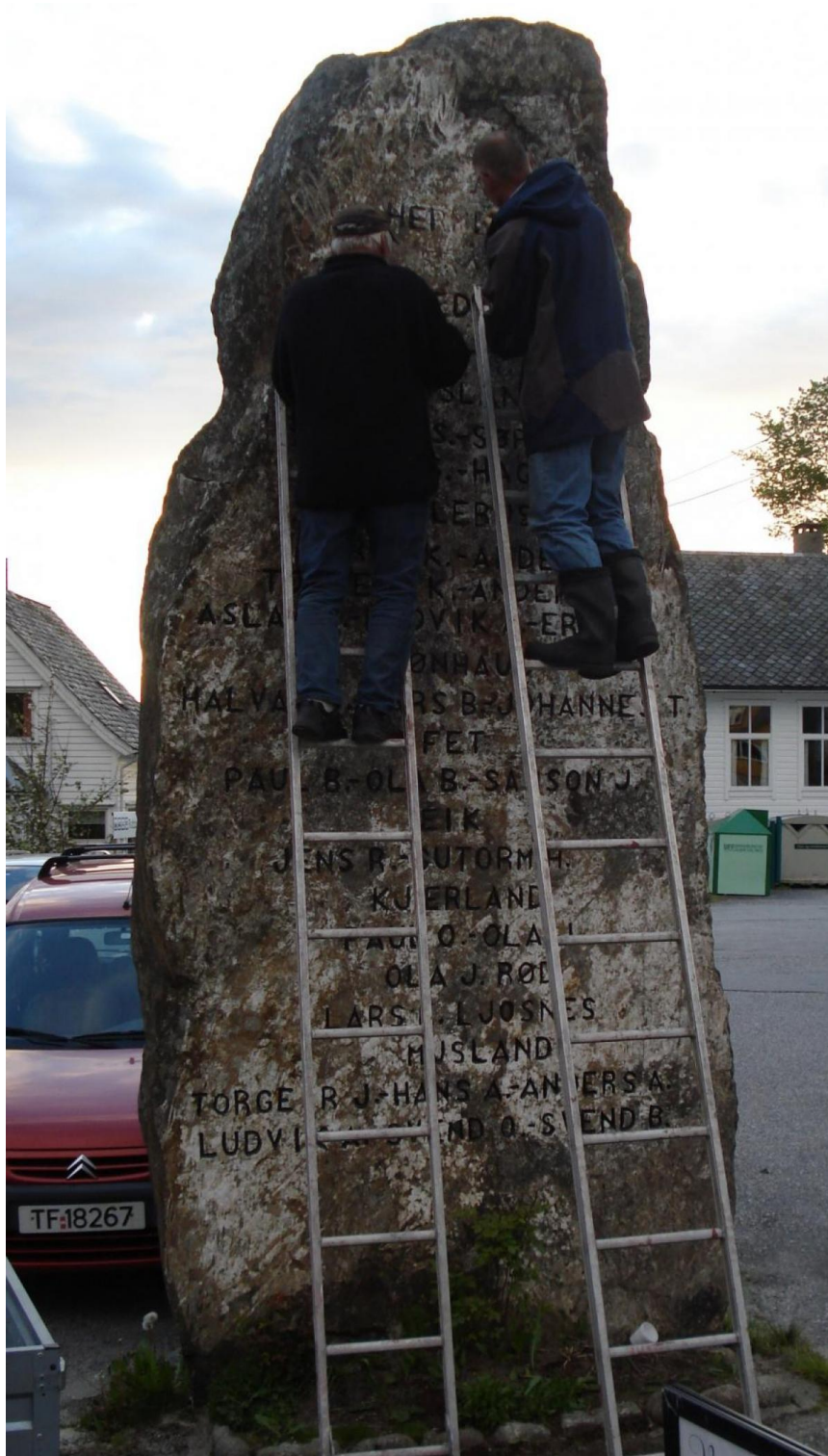
Audun Eik og Kåre K. Rød i ferd med å avslutte det flotte oppussingsarbeidet.
