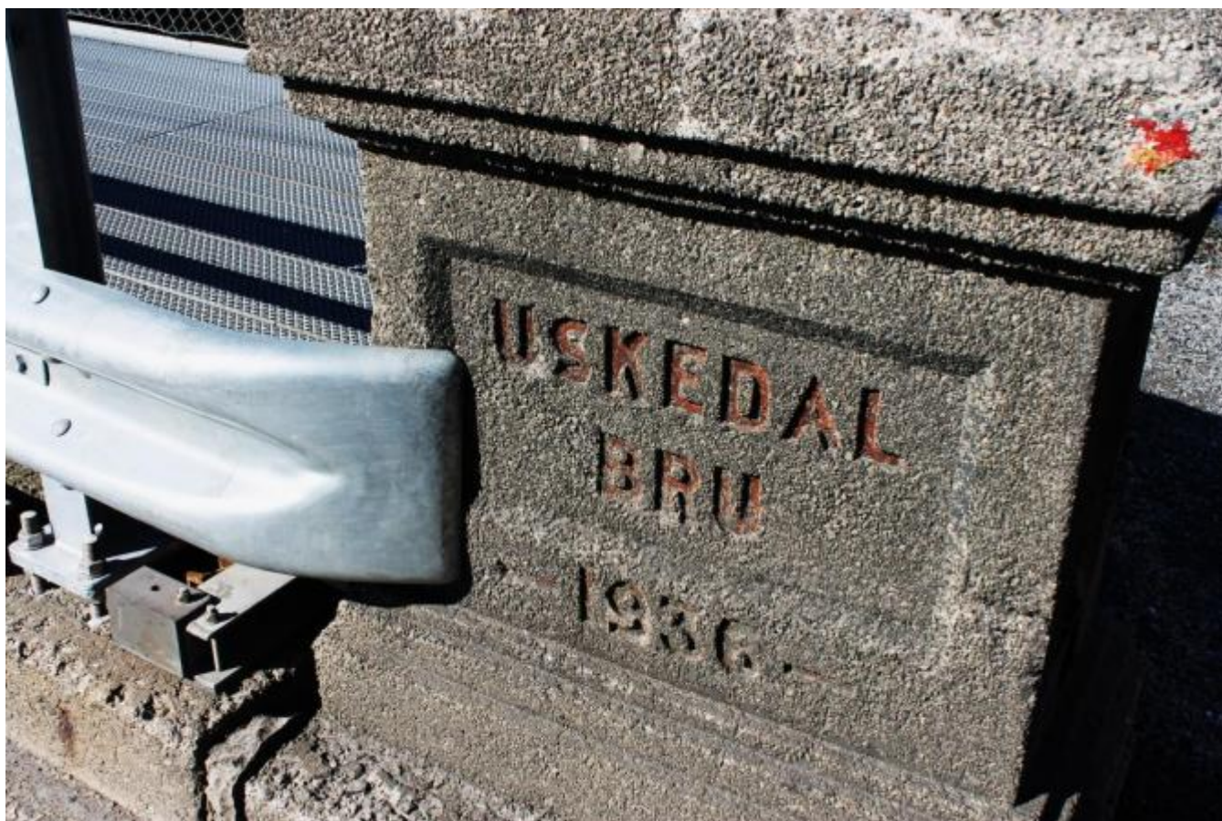
Brua som no restaurerast vart bygd i 1936
