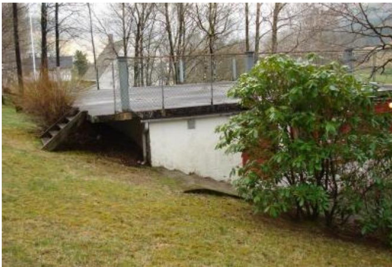
Bygget på stemneplassen treng vedlikehald.
