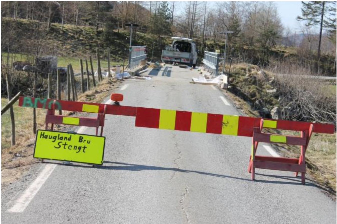
Hauglandsbrua er stengt under rehabiliteringa
