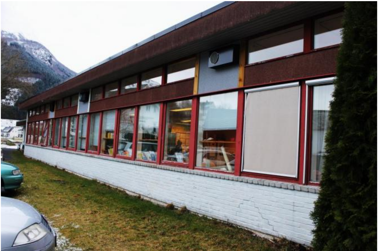
Nye yttervegger er ein viktig etappe under rehabiliteringa
