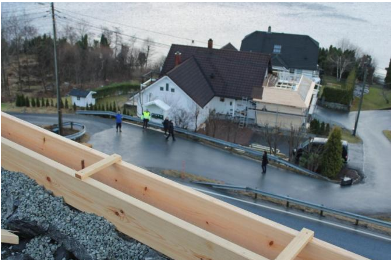
Slik er utsikten frå muren mot fylkesvegen og området nedanfor
