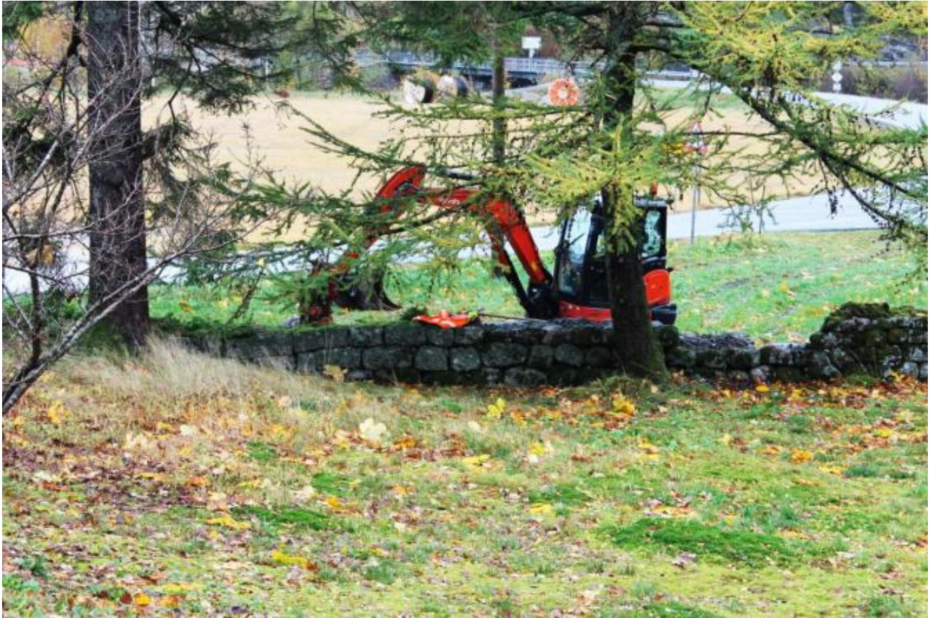
Tor Ove Haugland reparerer no skade nummer to
