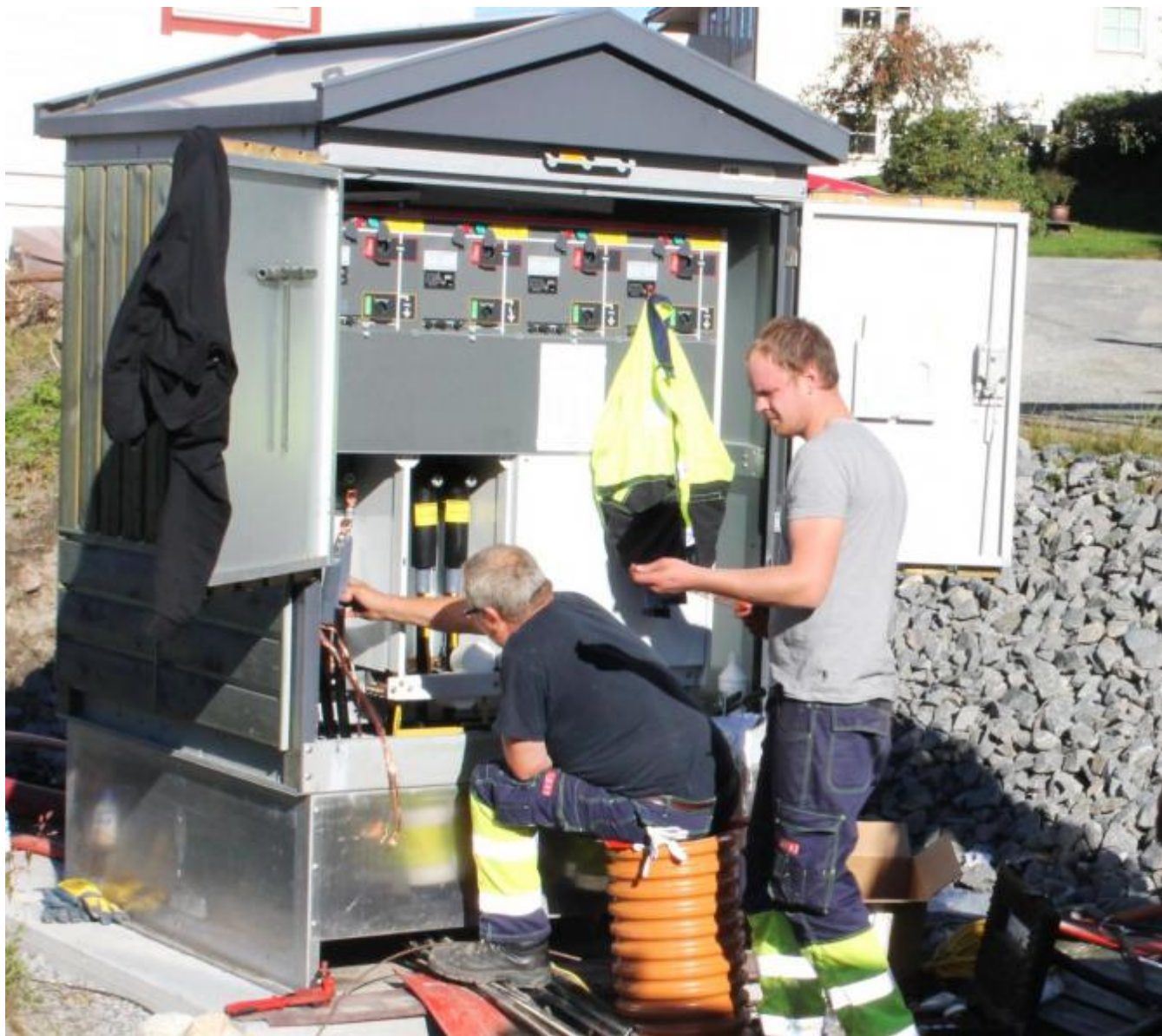
Kvinnherad Energi igang med koplingsarbeid ved brua i dag
