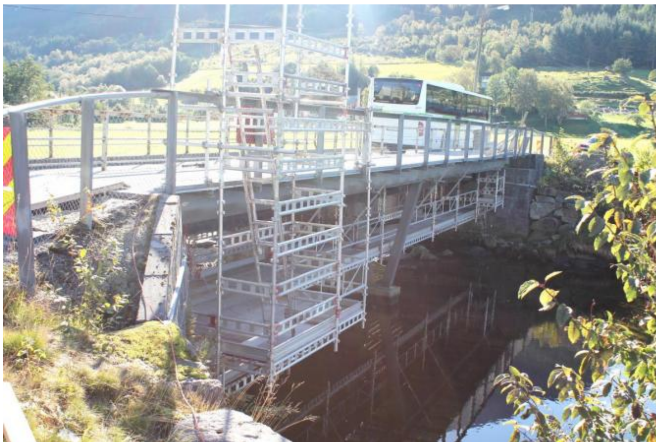
Høgspintlina skal no gå i eit røyr under brua
