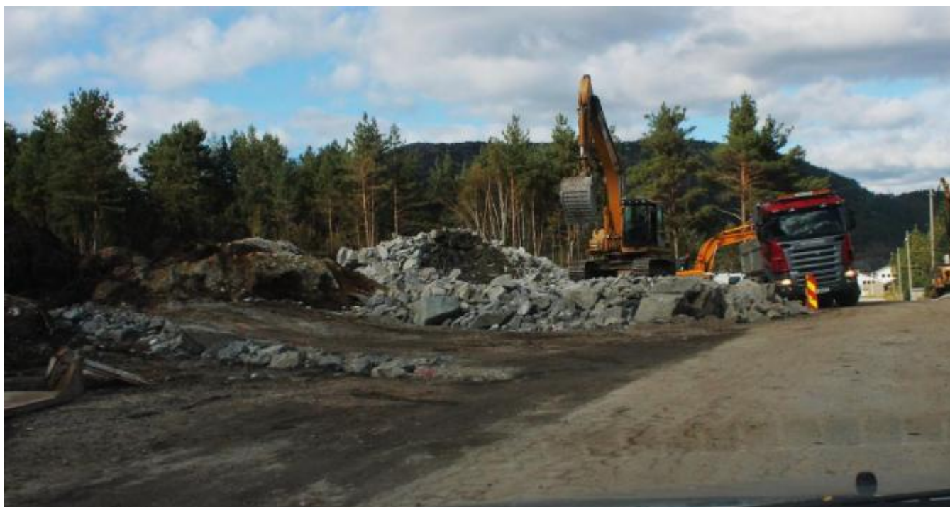
Røsseland arbeider for fullt med opparbeiding av tomtane. (Foto: Ola Matti Mathisen)
