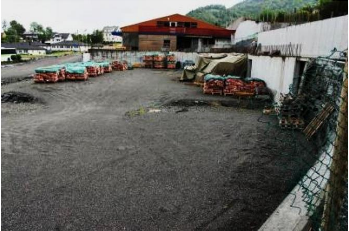
Kva vert det til med KV-tomta? Det veit ingen i dag.
