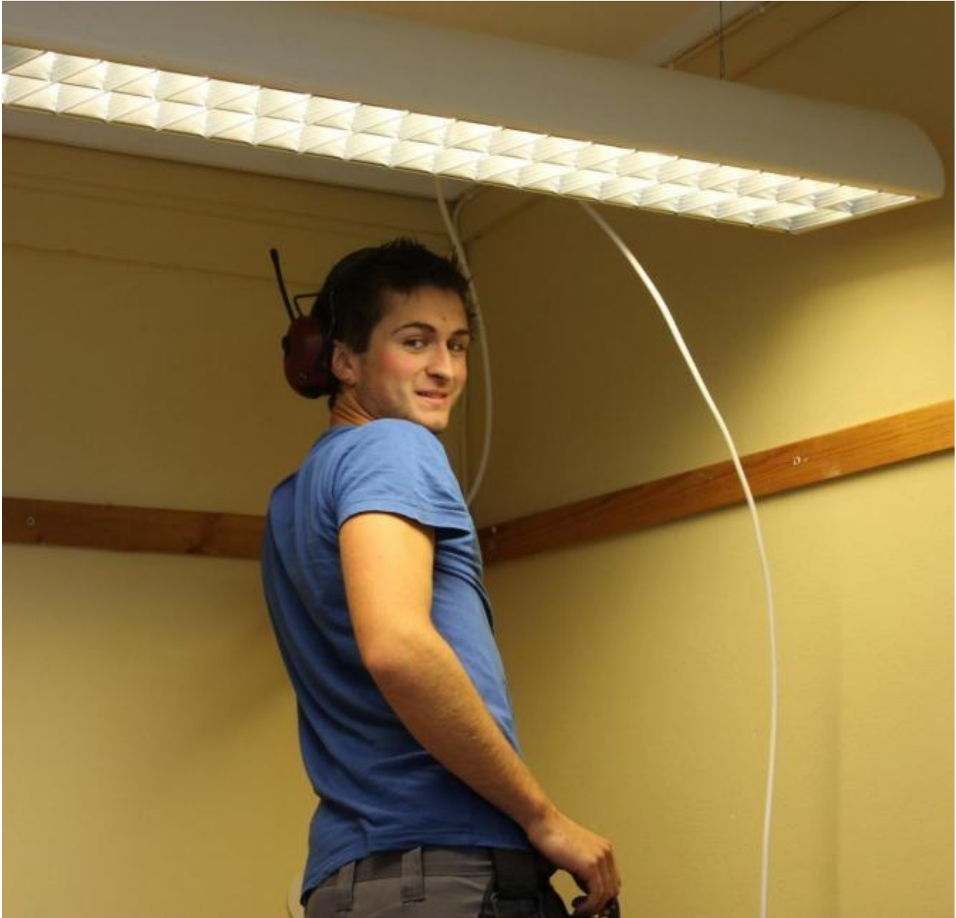
Andreas Bernhardsen monterer el-anlegget. Han er tilsett i Kvinnherad Elektro
