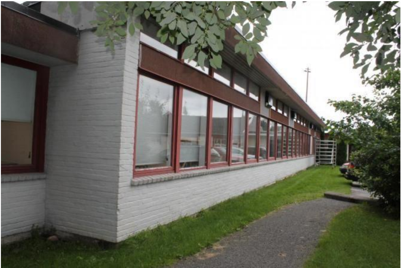
Ventilasjonsanlegget dekkjer 8 rom
