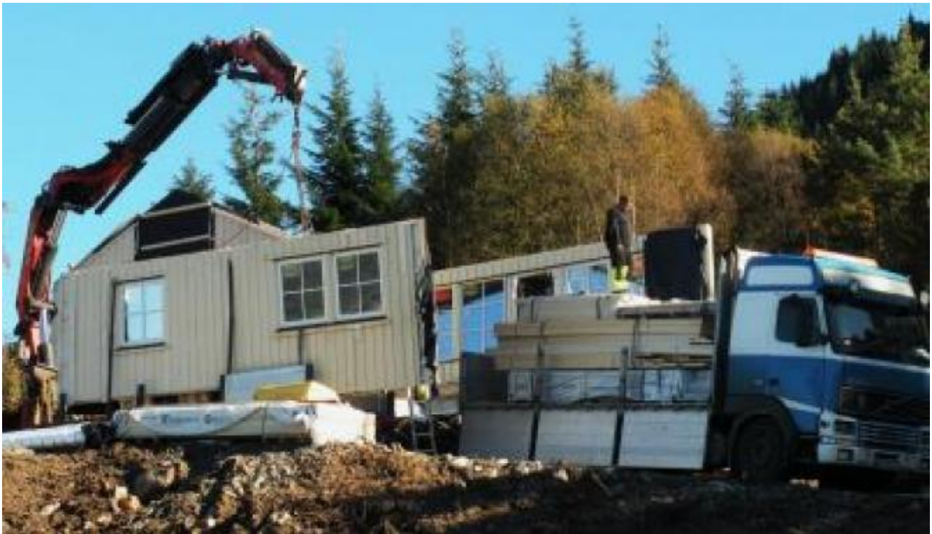
Berre eitt hus er montert i Ospelunden i dei seinare åa
