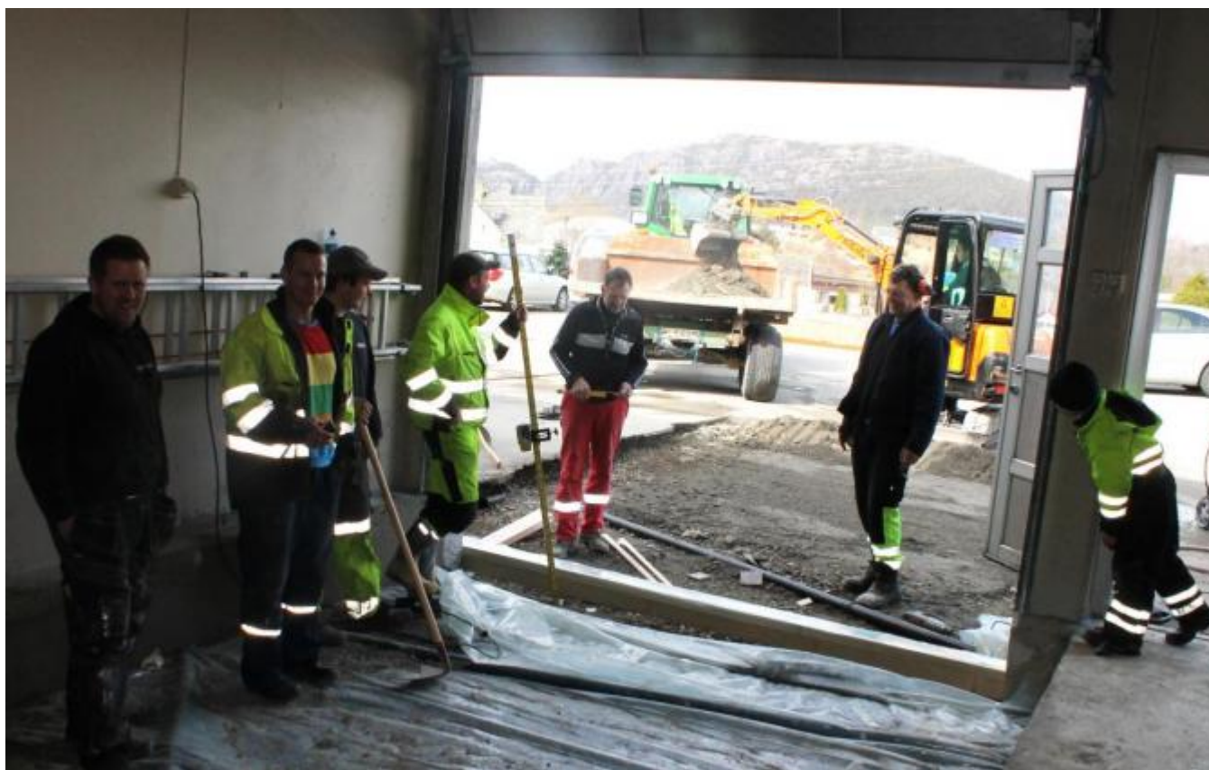
Støypinga av nytt og seinka golv har vore igang i dag
