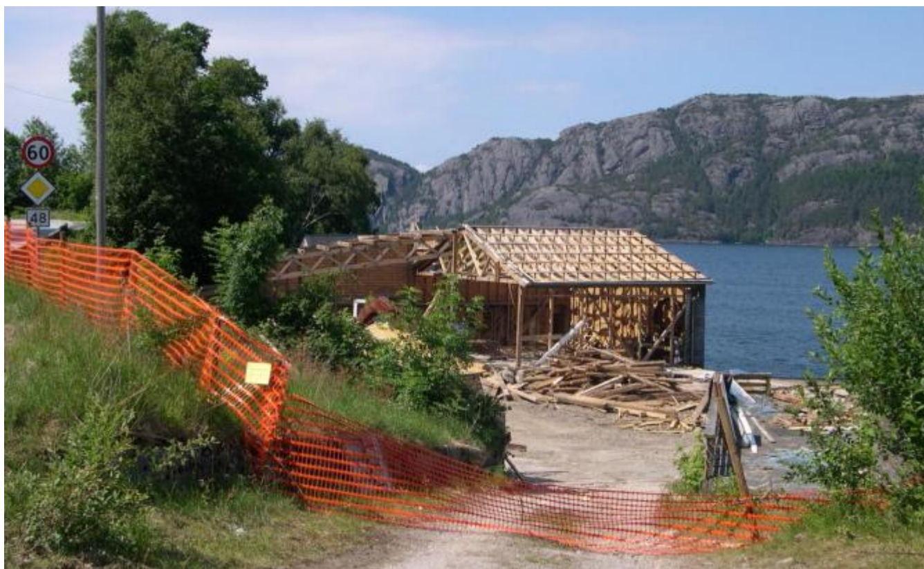
Dei siste restane av trelastlageret på Eiklandet vart reve sommaren 2006
