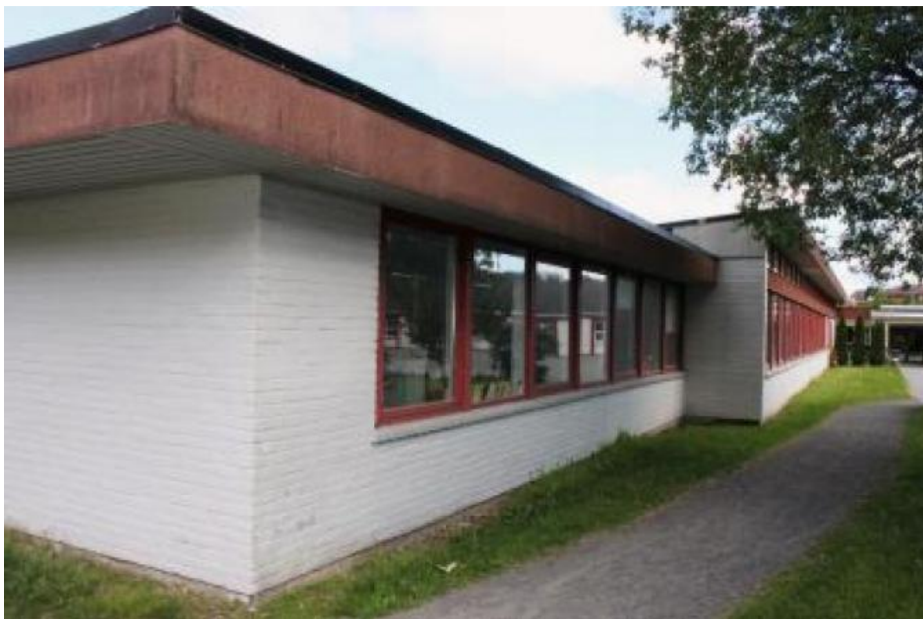
Dette er fløyen som etter planen skal renoverast.
