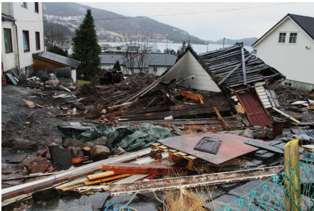
Røykstova, på folkemunne kalla Geitebuhuset, har kollapsa fullstendig
