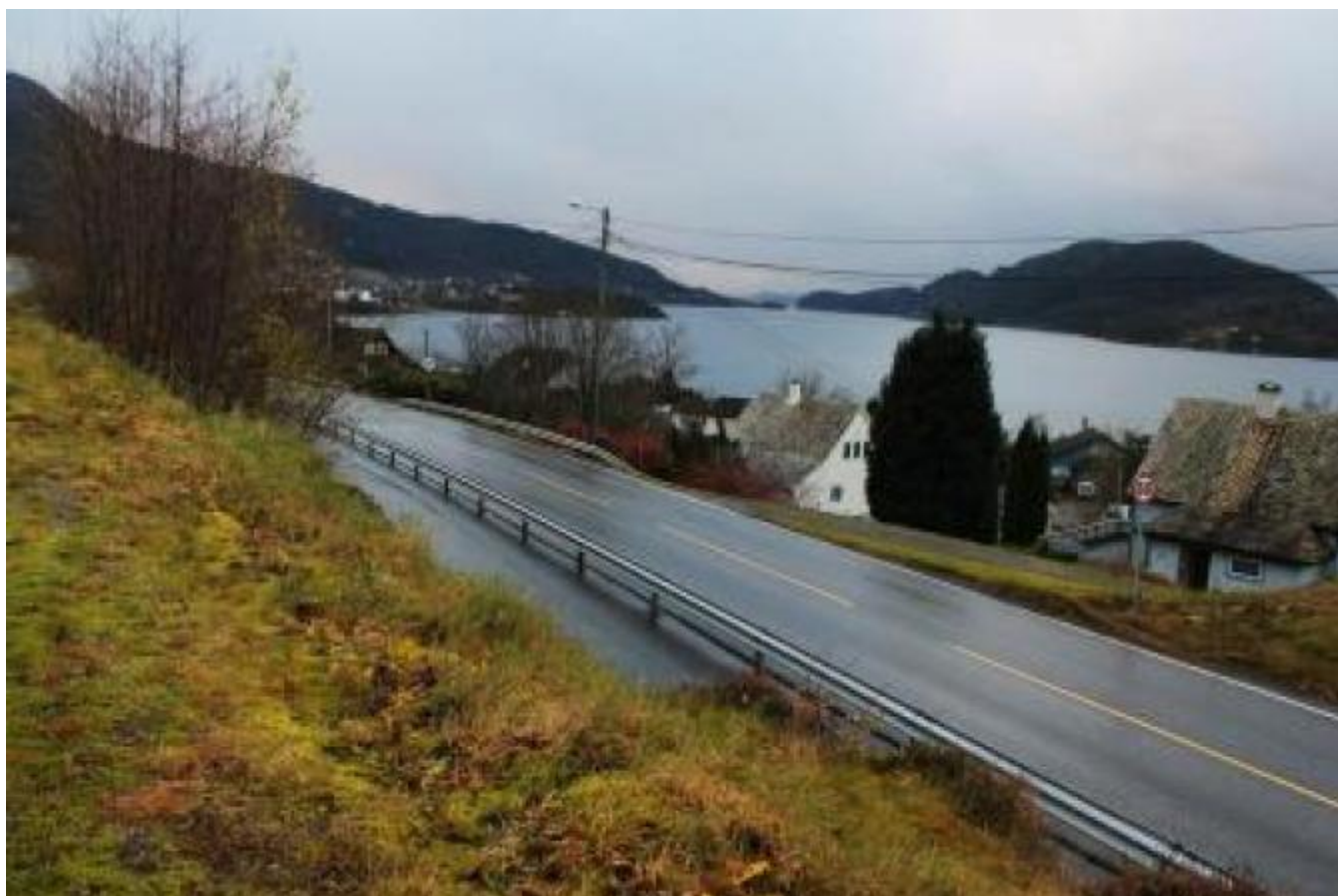
Frykt for overvatn nedanfor fylkesvegen er framleis eit problem for Ospelunden-prosjektet
