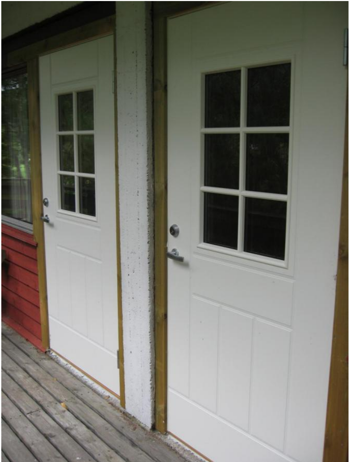
Nye ytterdører på Stemneplassen
