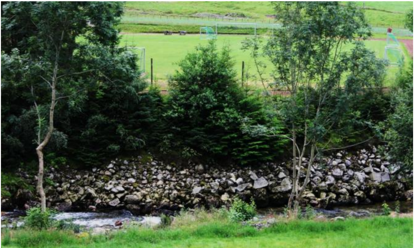
På denne strekninga treng ein forbygging (Foto: Ola Matti Mathisen)
