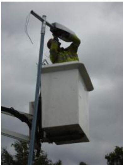
Kvinnherad Energi står for monteringsarbeidet.
