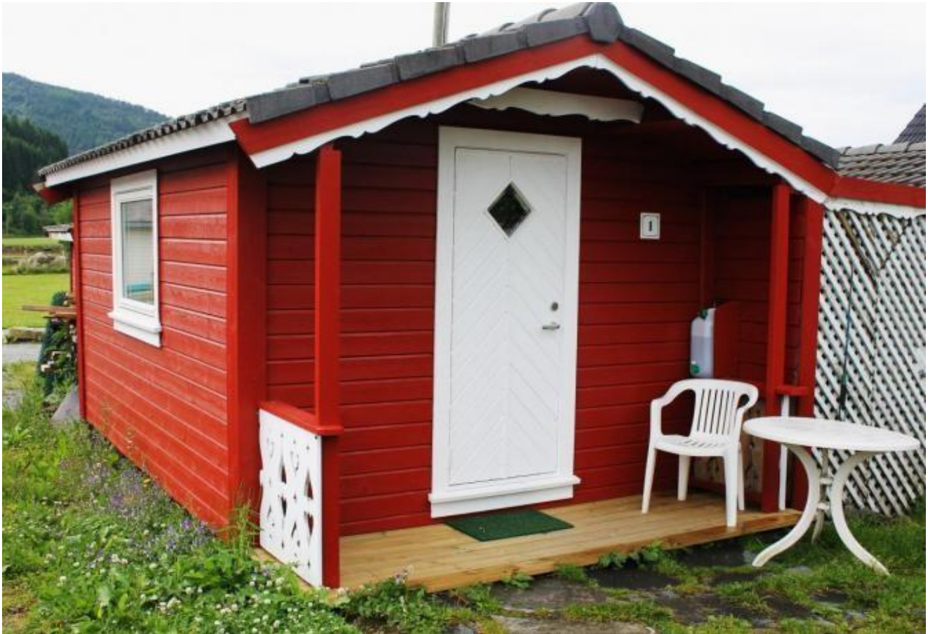
3 av 6 slike hytter er no renovert
