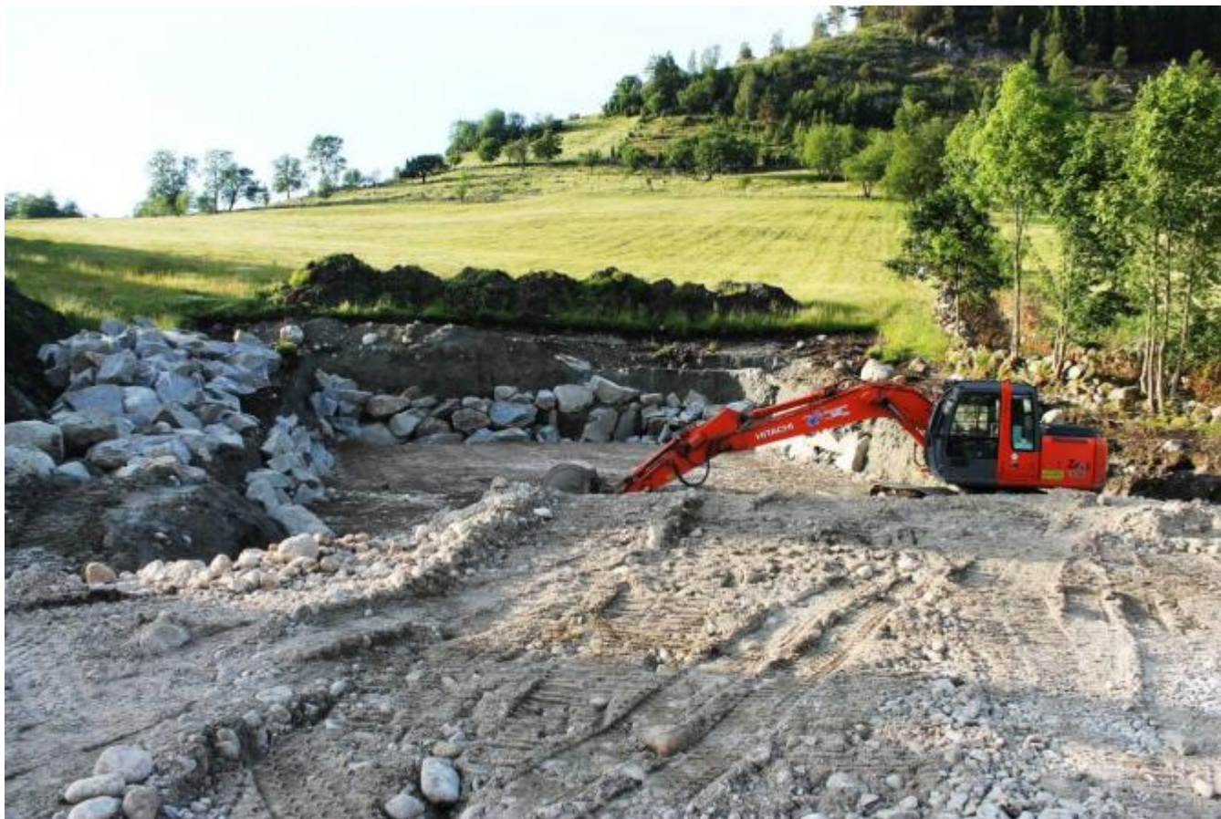
Tomta er klar og snart skal det byggjast for over 200 vinterfora sauer på Myklebust
