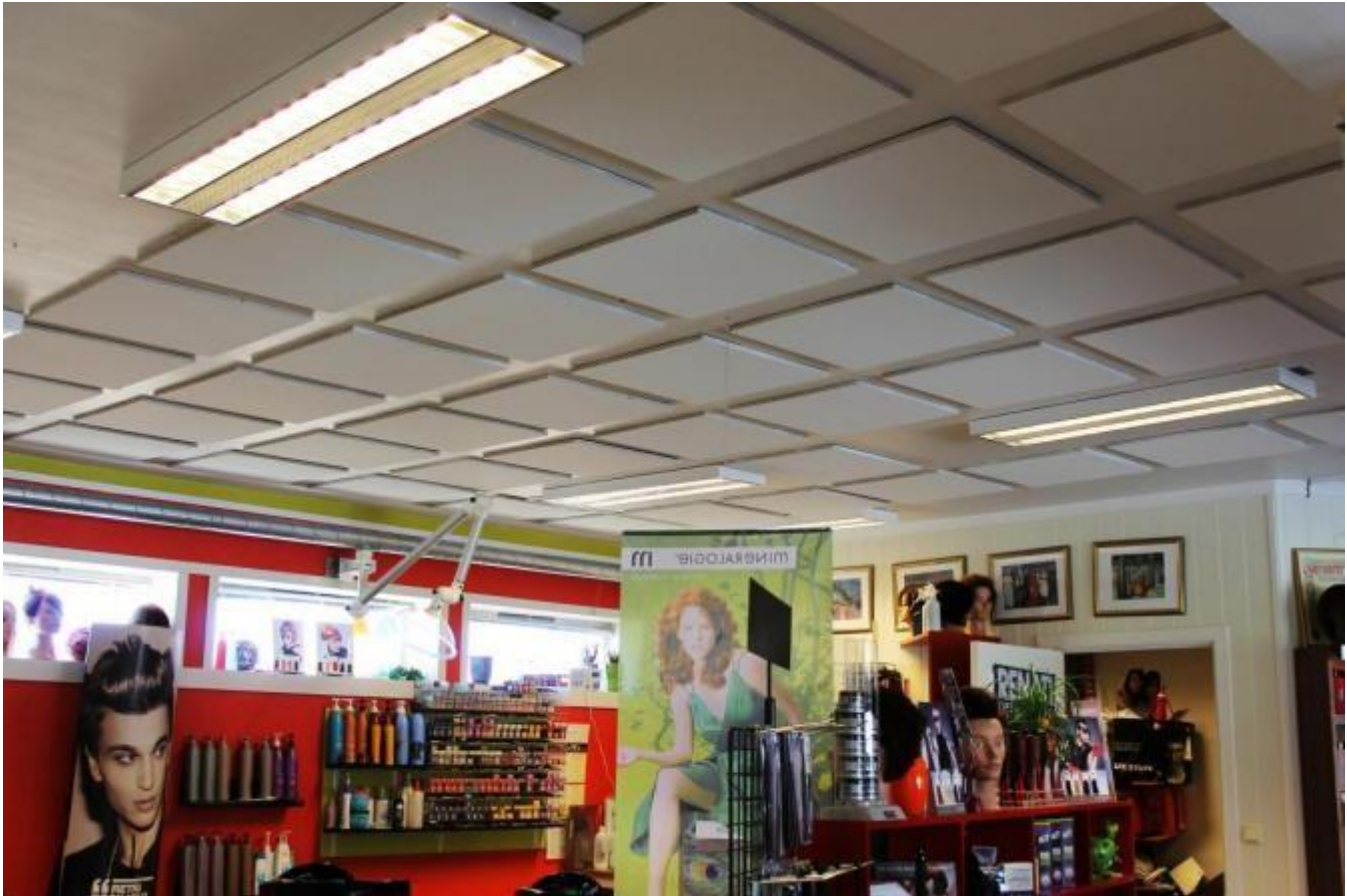
Det vart montert plater i heile taket
