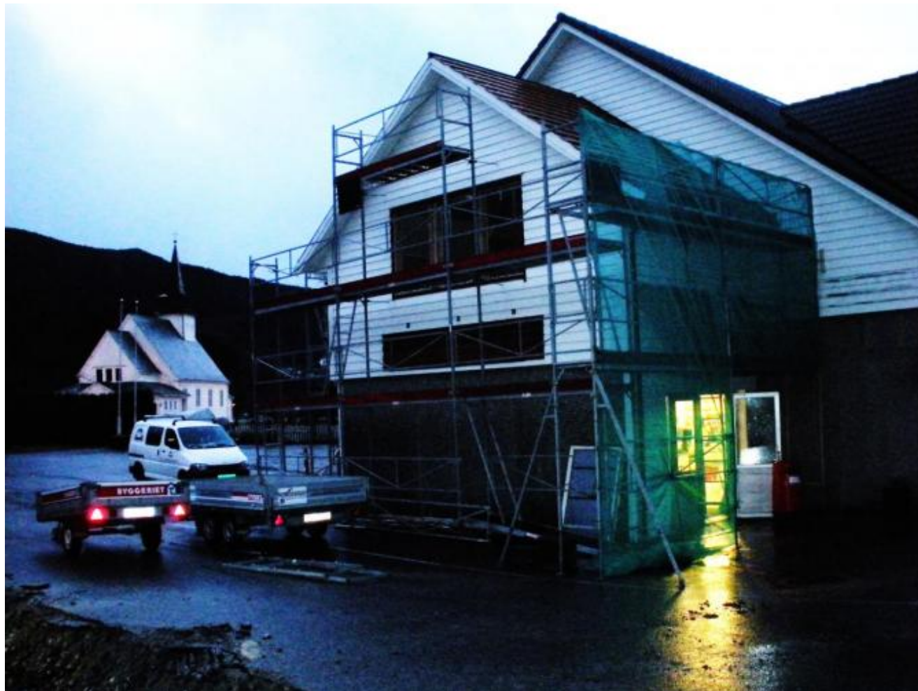
Enden av noverande bygning skal rivast
