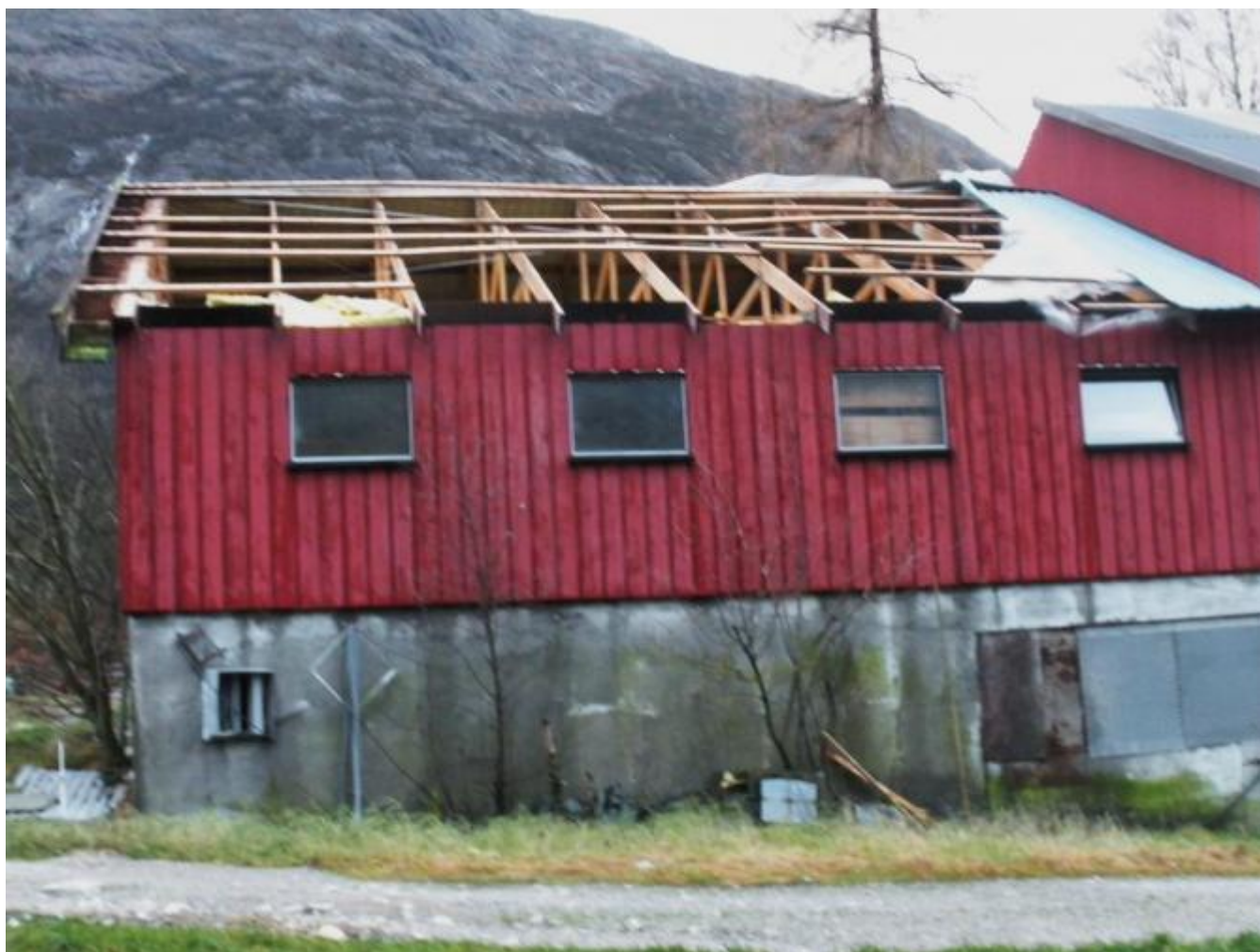
Halve taket vart rasert hos Kåre Vetthus
