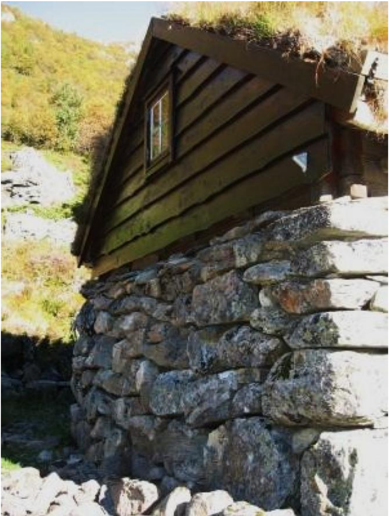
På Vatnastøl er det gjort ein stor restaureringsjobb
