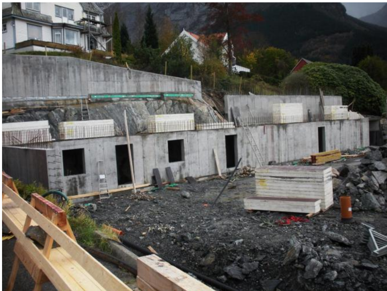
Slik er den støypte veggen i bakkant av tomta.
