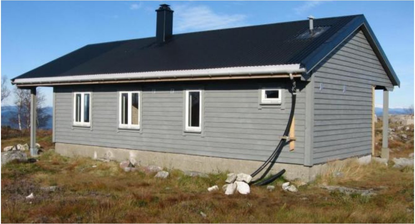
Hytta er renoverert med nye vindaugo, ny kledning og ny pipe.
