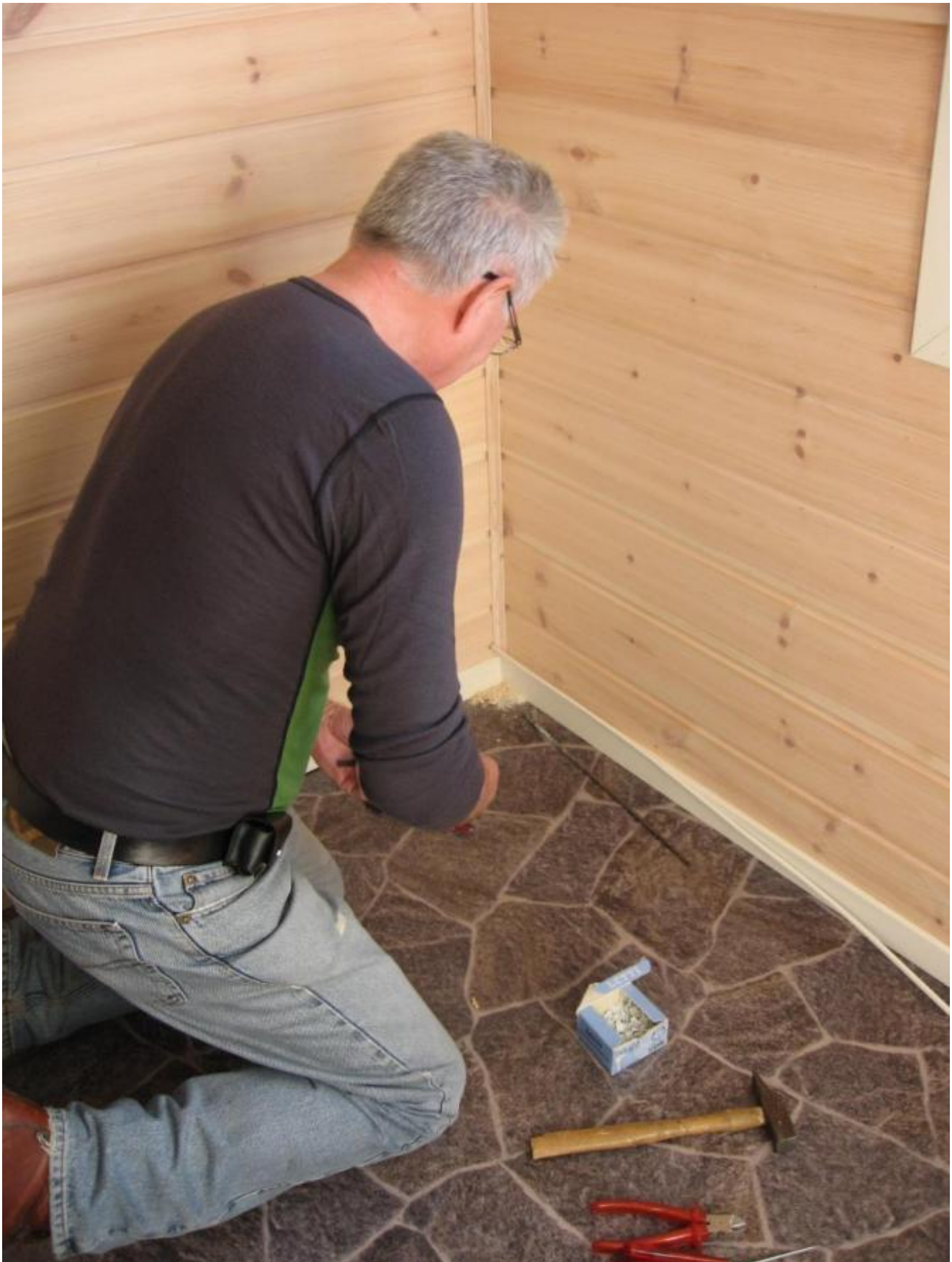
Leif Magne Framnes legg siste hand på verket, han legg kabel og monterer stikkontaktar.
