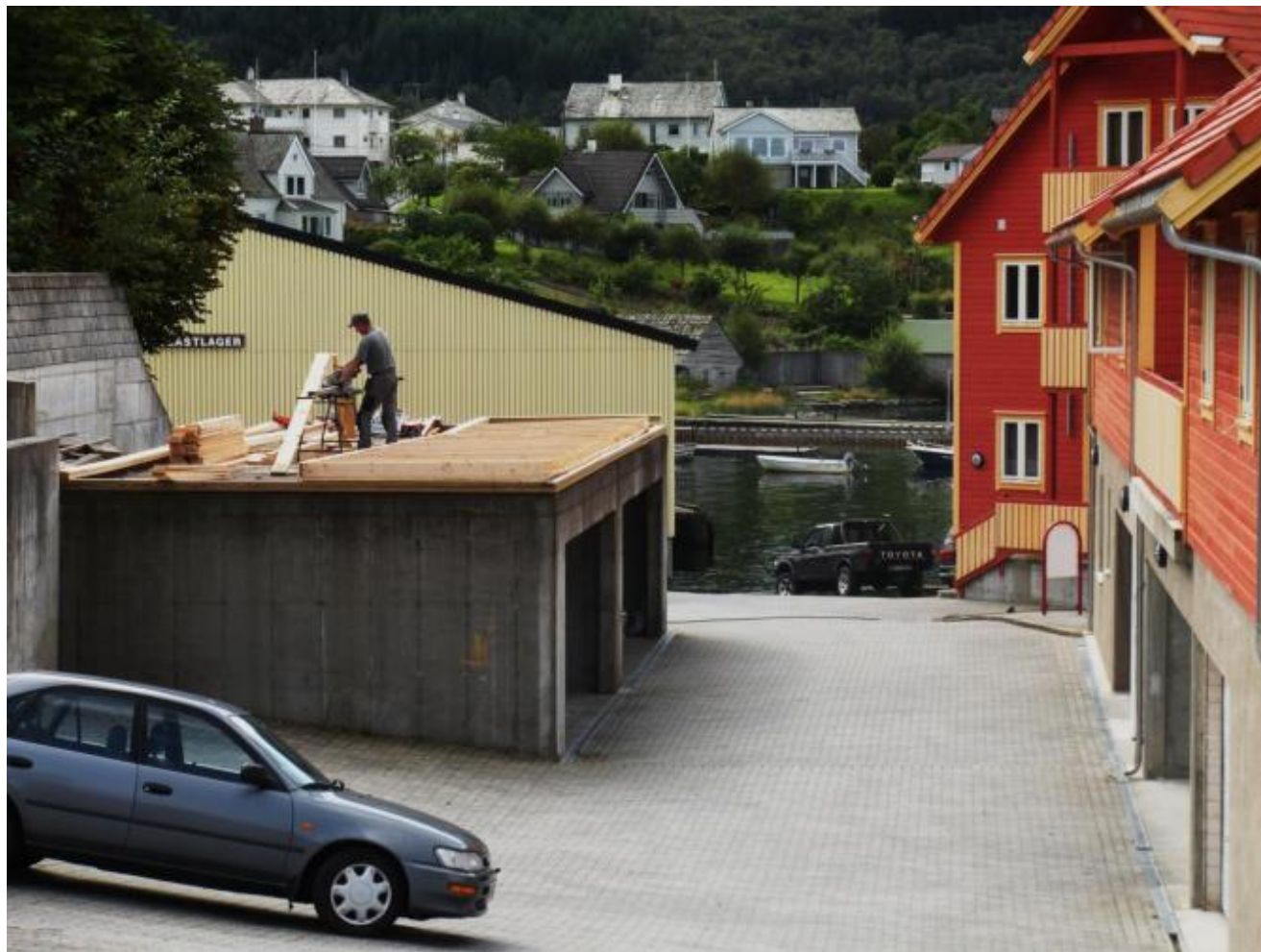
Arbeidet med eitt husvære til er no i gang - på etasjeskillet til venstre
