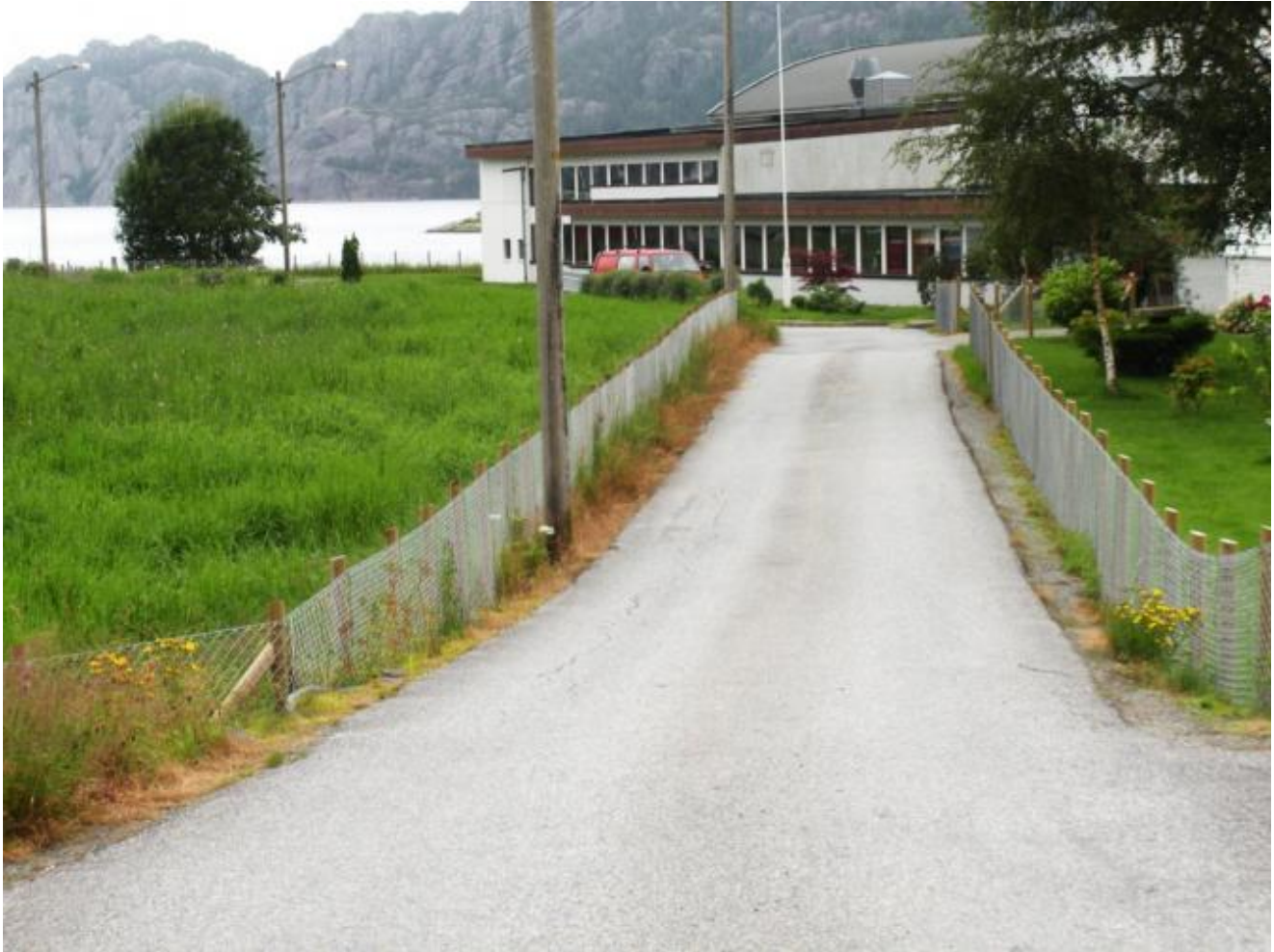
Det kjem truleg fortau på venstre side av vegen ned mot skulen. (Foto: Ola Matti Mathisen)
