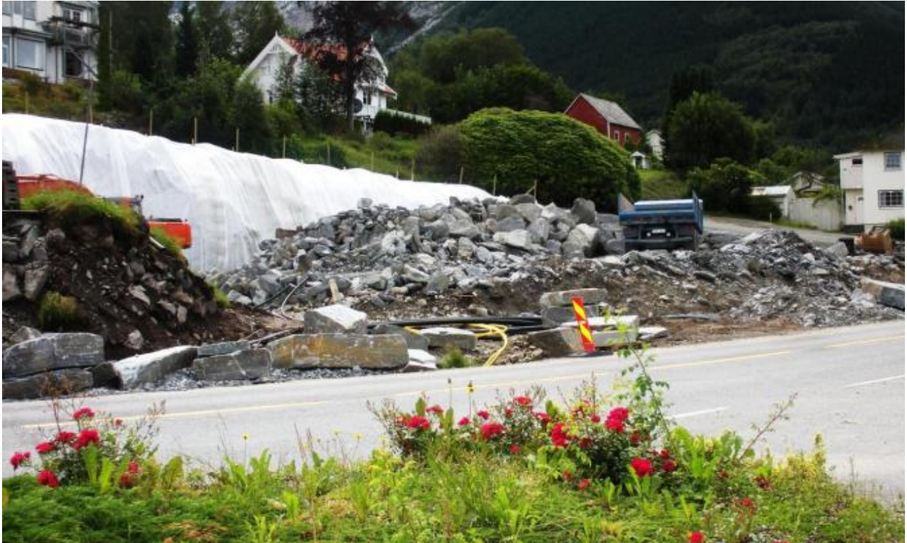
Akkurat no er det stillstand med tomtopparbeidinga på AFA-bygget (Foto: Ola Matti Mathisen)
