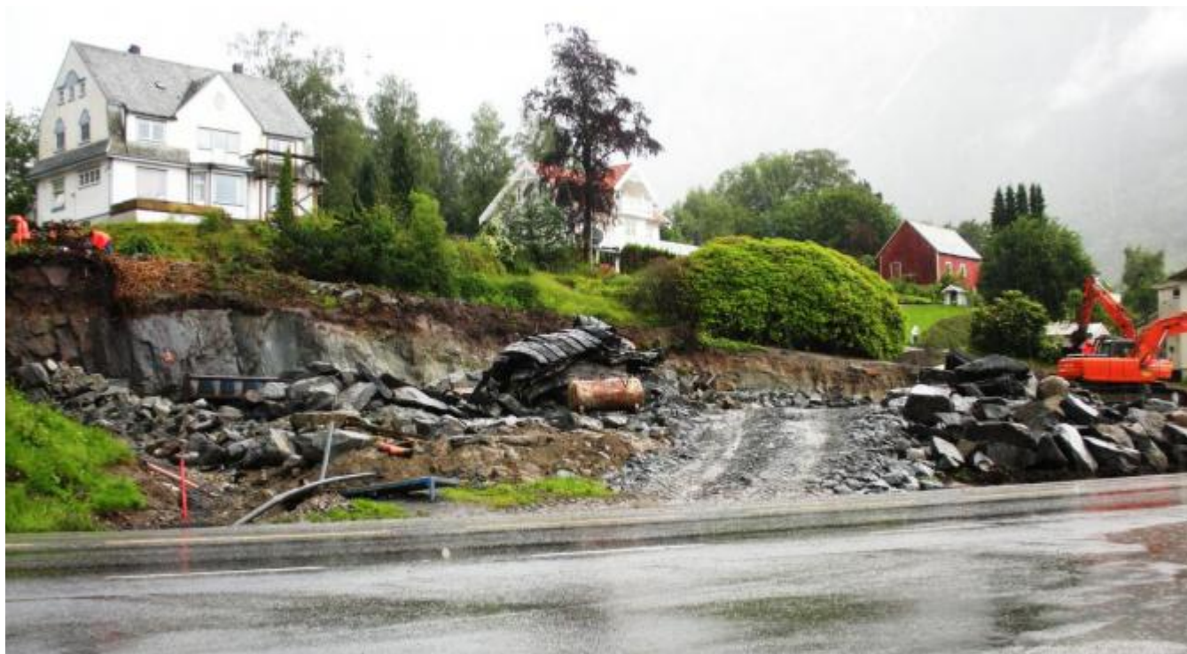
Tomtearbeidet nærmar seg no slutten
