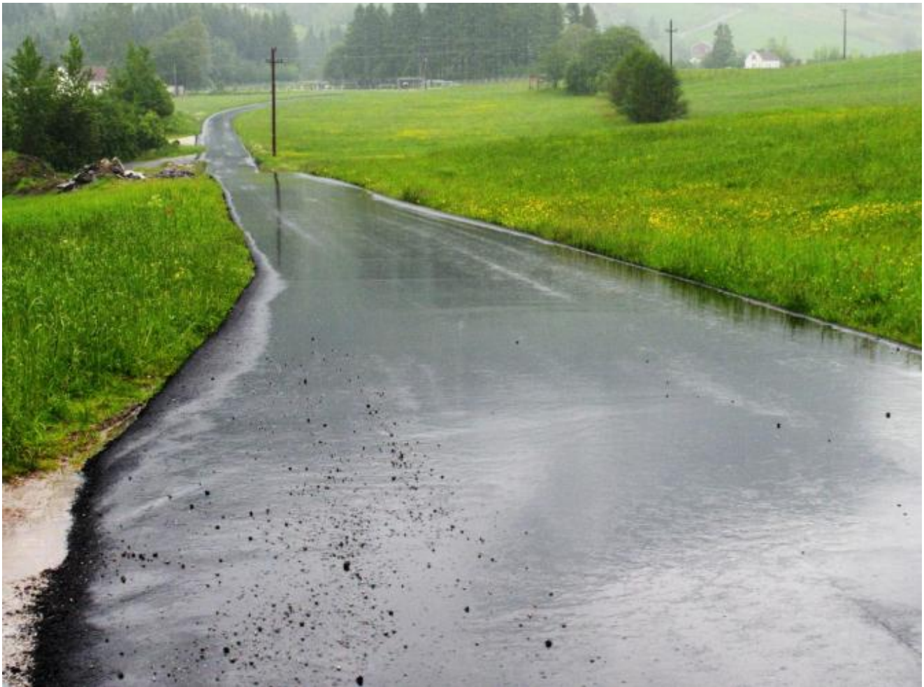
Asfalteringsarbeidet blir rosa av oppsittarar
