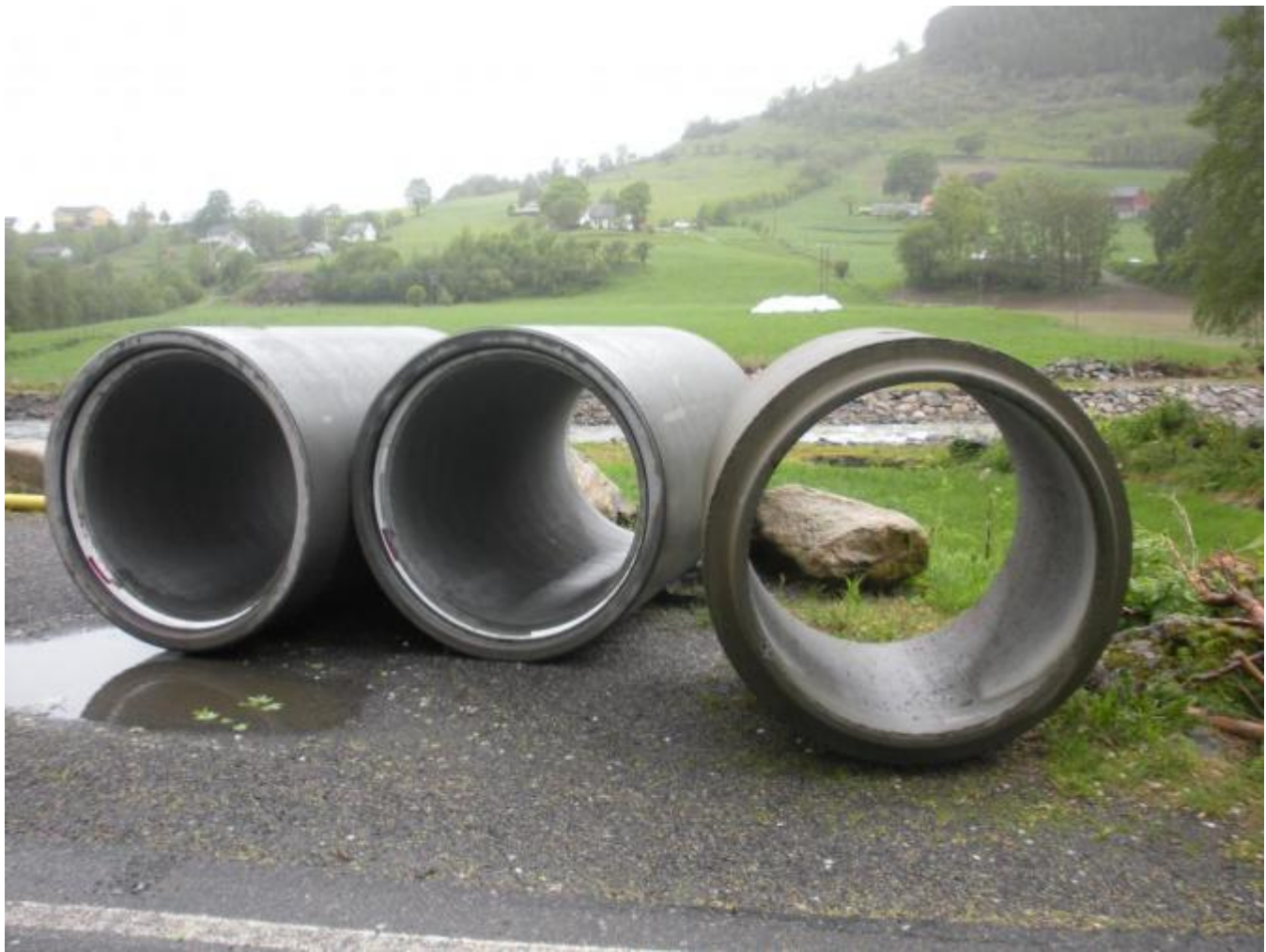
Skiftesbekken får solide røyr
