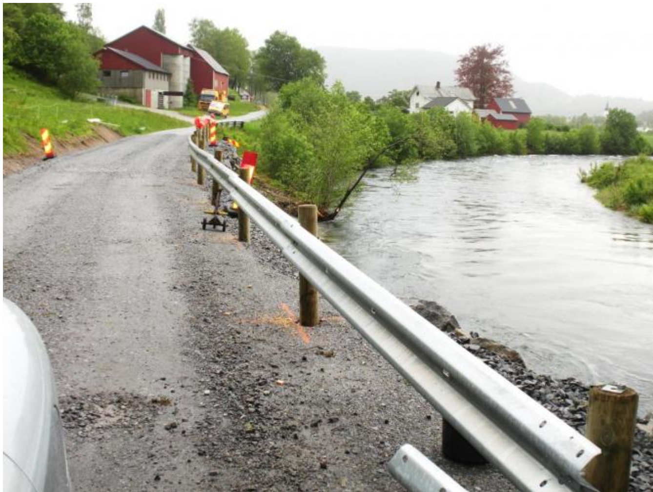
Rekkverket ved Djupehølen er snart ferdig.
