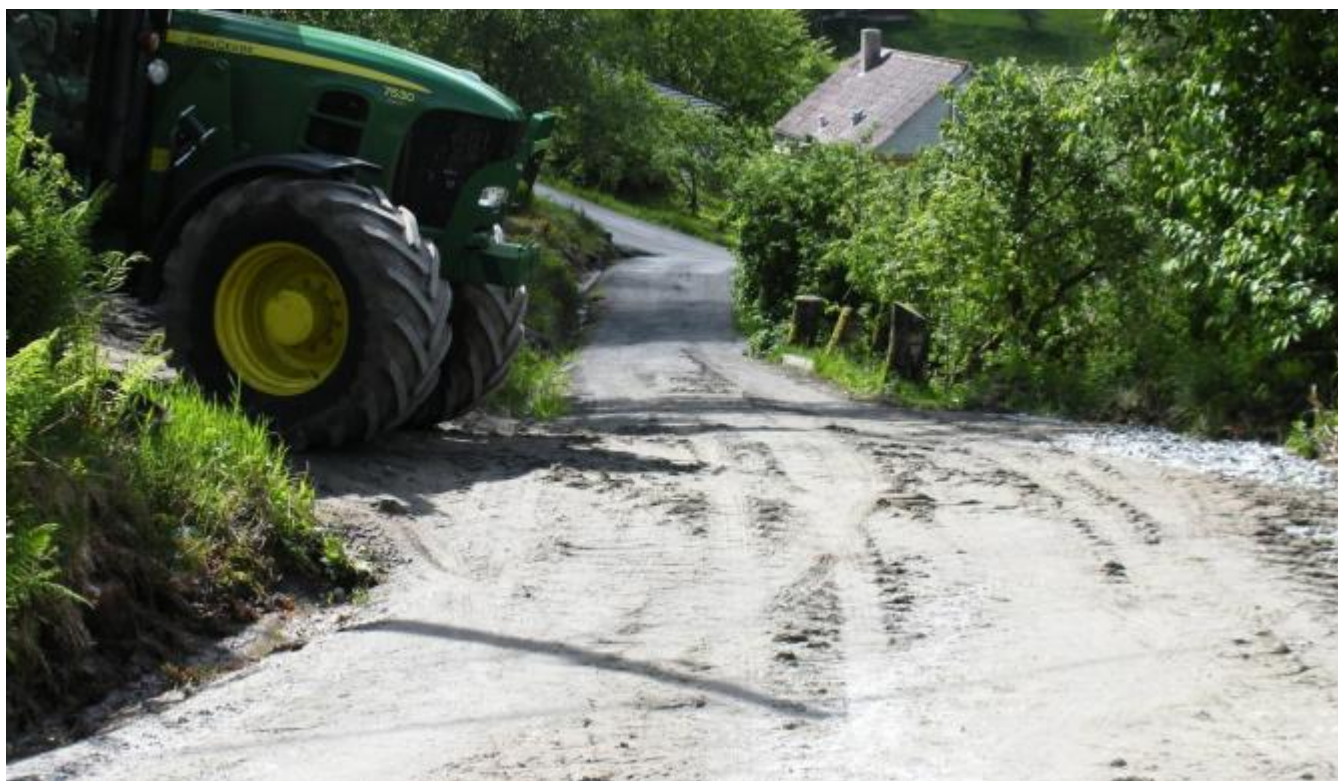
Her blir det 130 meter ny asfalt.
