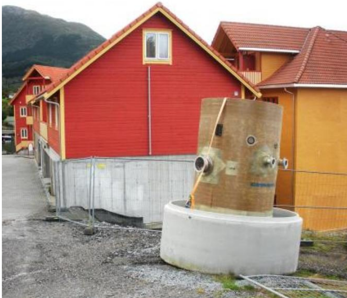
Kloakkanlegget har vore eit prosjekt med mange etappar, Her er pumpestasjonen ved Uskedalen Brygge undervegs (Foto: Ola Matti Mathisen)
