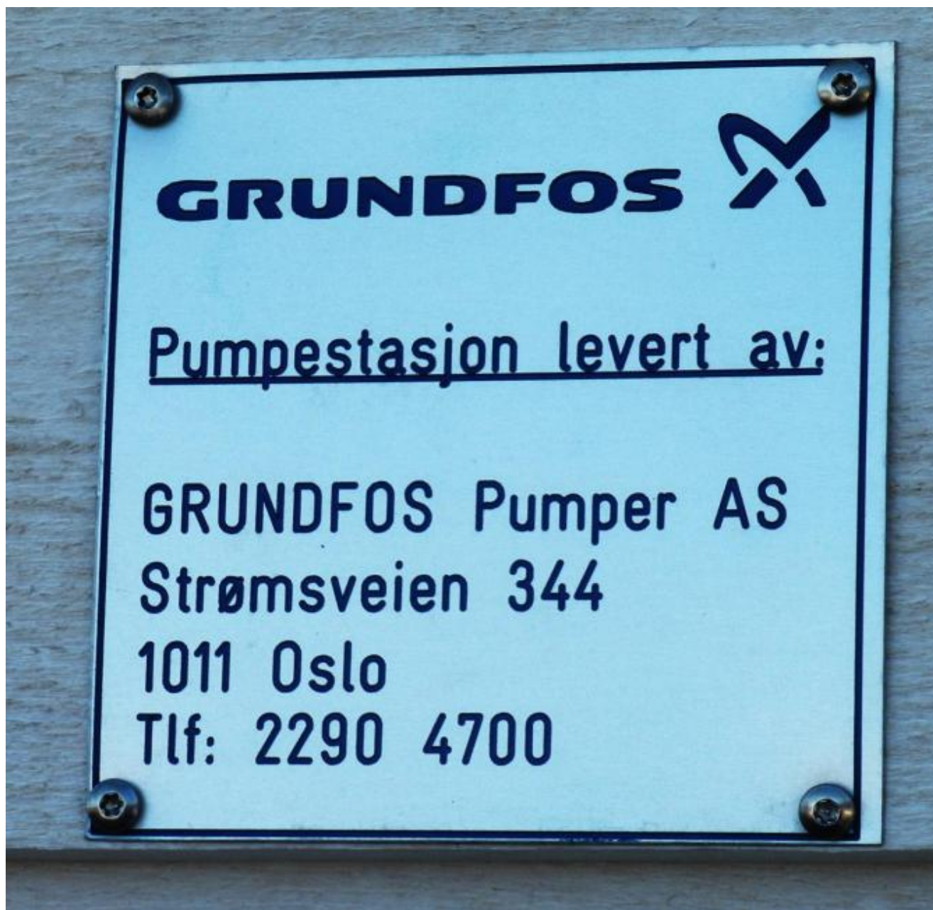
Det er Grundfos som har levert pumpeasjonane.
