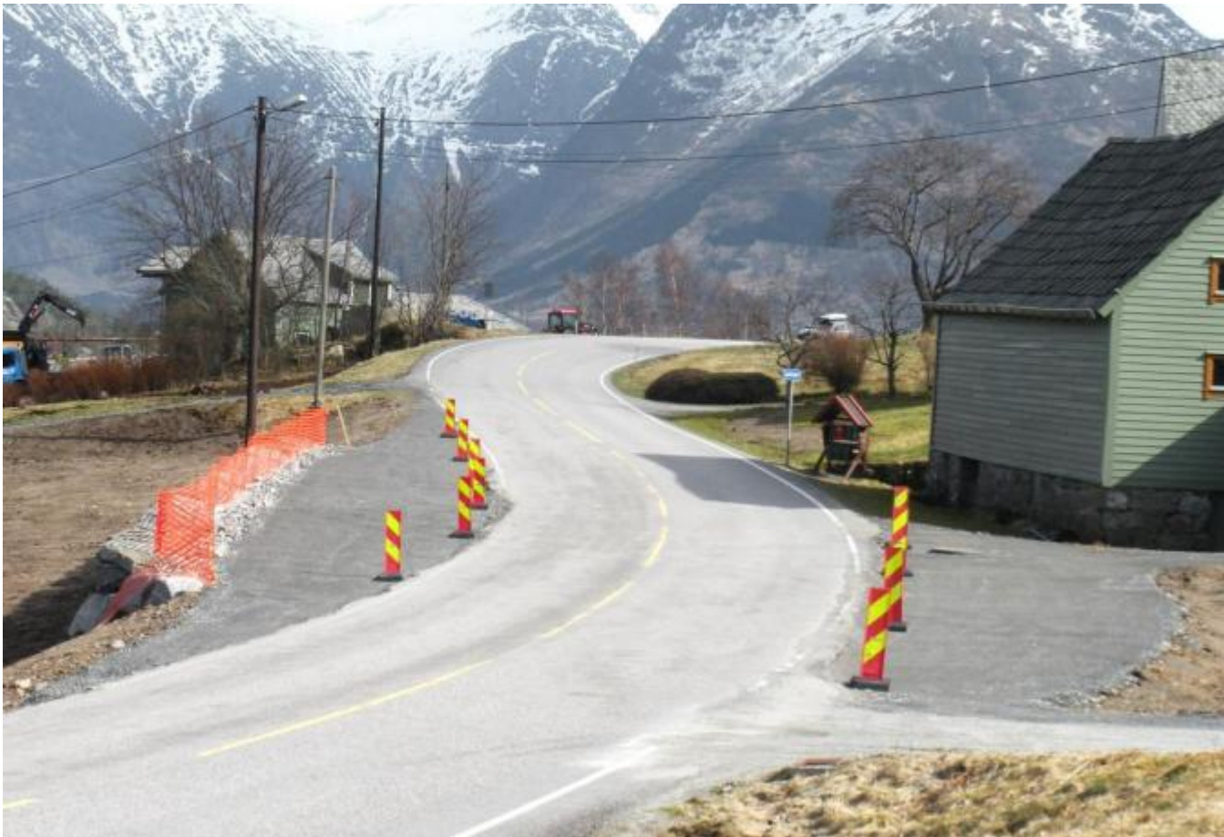
Mykje av Ljosnes-jobben er gjort - med busslomme på utsida og buss-stopp på innsida av vegen.
