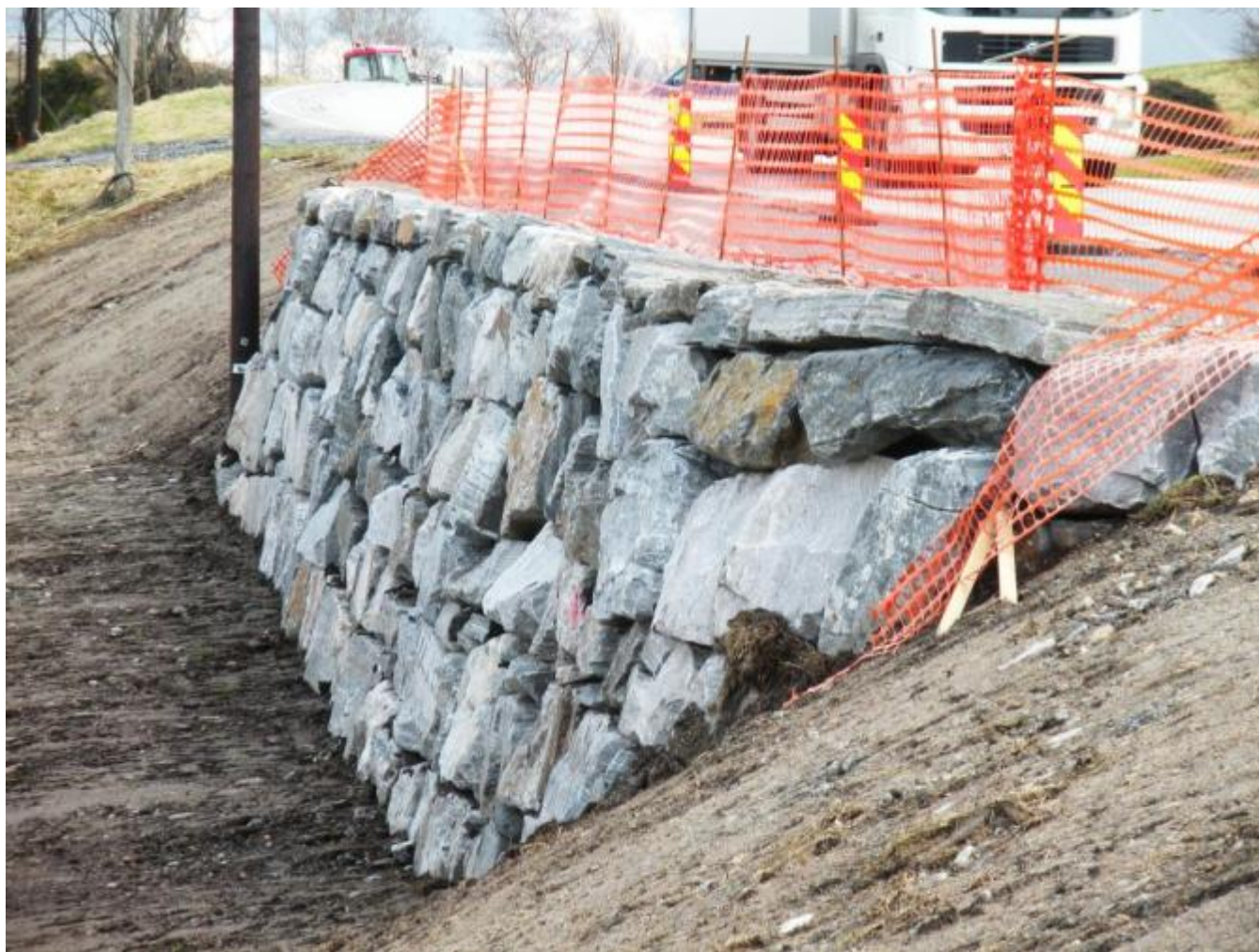
Solid mur av vanleg vegvesen-standard er på plass.
